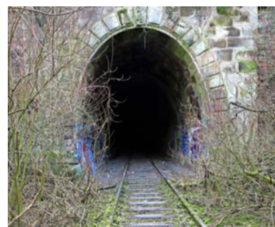
Seit 2015 ist der Lerchenbergtunnel von Norden her wieder frei zugänglich.
