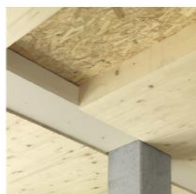
Hybrid-Konstruktion, bestehend aus Stahlbetontragwerk und Holzmassivbauelementen
