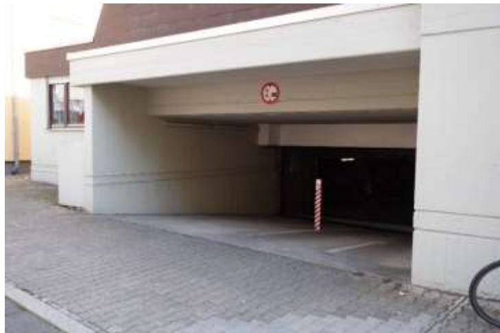
Abbildung 16: Ein-Ausfahrt private Tiefgarage Wolfganggasse 16/18
