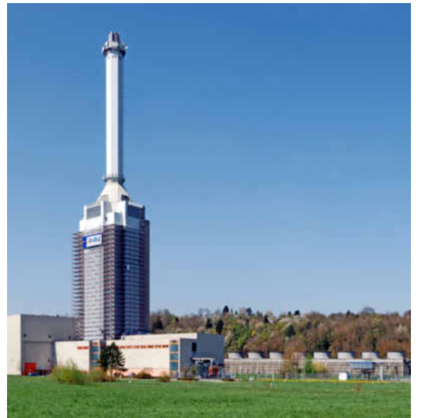
Auch das Kraftwerk Marbach ist in der Netzreserve. Hier entsteht gerade eine Netzstabilitätsanlage auf Basis einer Gasturbine. Foto: Felix König
