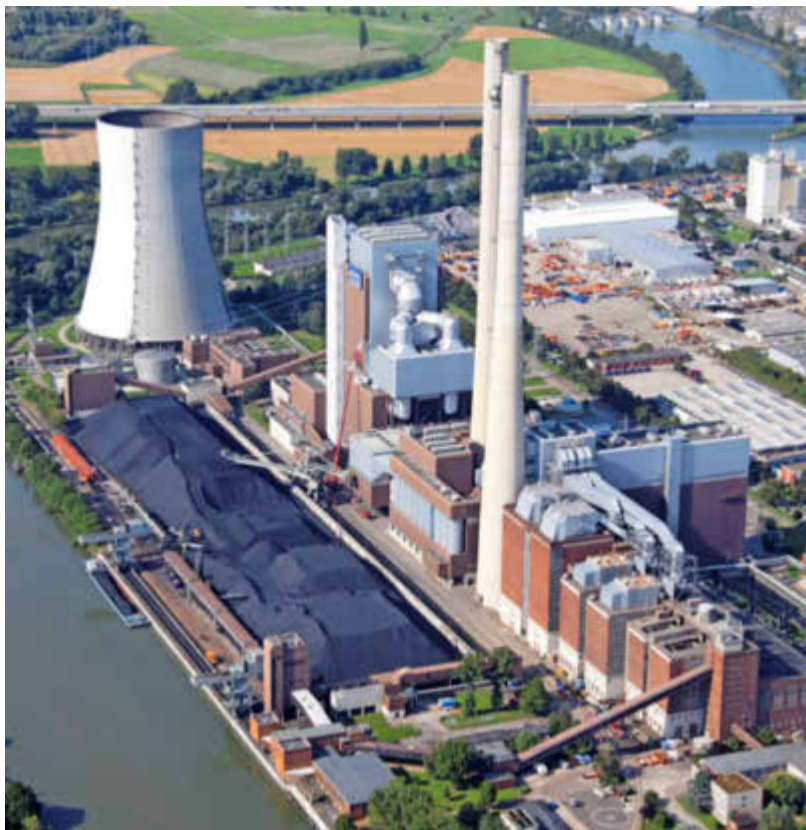
Das Kohlekraftwerk von Heilbronn soll 2026 abgeschaltet werden. Auf dem Bild rechts neben dem Kühlturm ist eine Gasturbine geplant. Foto: Daniel Maier-Gerber
