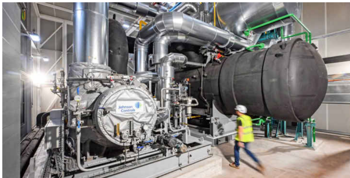
2024 wurde die Großwärmepumpe am Standort Stuttgart-Münster nach einer Probephase in Betrieb genommen, sie dient als Pilot- und Demonstrationstechnologie. Nach Unternehmensangaben liefert sie Fernwärme für 10 000 Haushalte. Foto: EnBW
